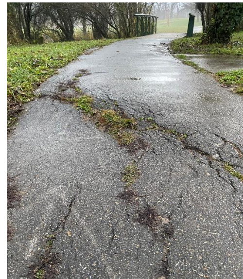
Réfection de cheminements déformés parc du Bruchet
